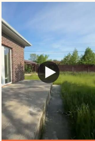
Дом и участок после строительства
